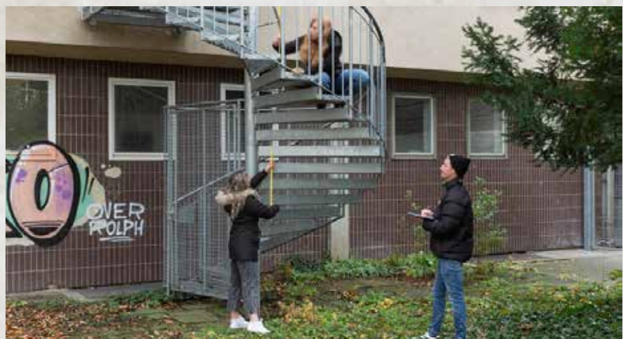
Die Außentreppe der ehemaligen Augsburger Stadtbücherei fand ein zweites Leben an einem Wohnhaus in der Oberpfalz.
