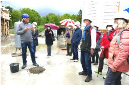
Baustellenbesichtigung mit der Lokalen Agenda, der Architektin Mascha Zach und dem Lehmbauer Martin Rauch am 18.5.2021. Foto: Norbert Pantel
