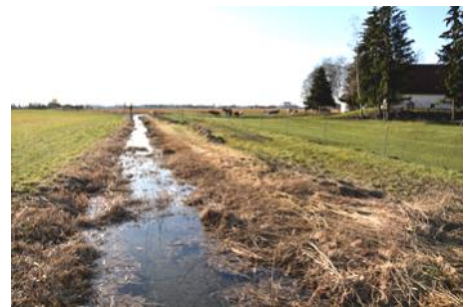
Der Höhgraben wird mit einem speziellen Mähkorb gepflegt. (Fotos: Landschaftspflegeverband)
