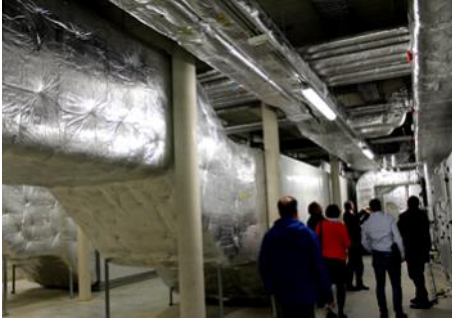
Führung durch das Schulgebäude.
