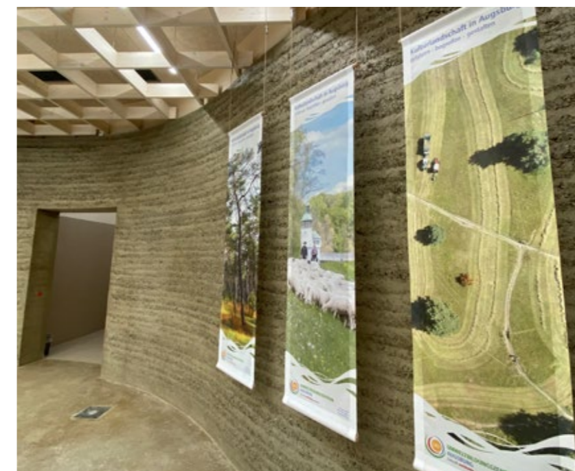
Ein Blick in das Forum des Umweltbildungszentrums. Gut zu erkennen sind die Wände und der Boden aus gestampftem Lehm. Foto: Torsten Mertz
