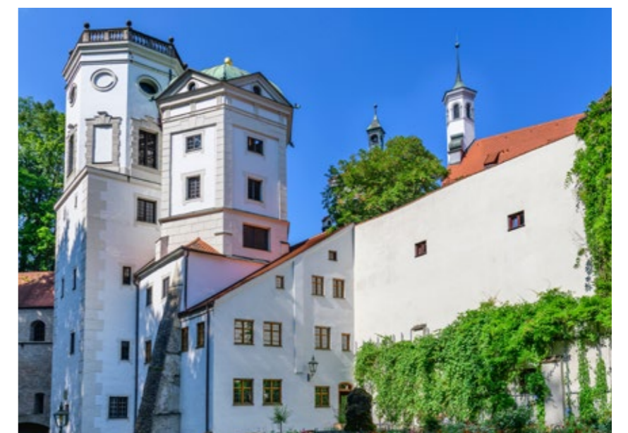
Das Ensemble der drei Wassertürme am Roten Tor ist Teil des UNESCO-Welterbes. Ab etwa 1416 versorgte das wohl älteste Wasserwerk der Welt die Stadt mit Trinkwasser. Seine Pumpsysteme waren in ganz Europa bewunderte technische Einrichtungen. Foto: ARochau/Adobe Stock
